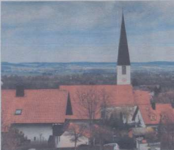
Das Ortsbild von Mamming wird durch die Pfarrkirche St. Margareta geprägt. Sie ist eine besondere Zeugin der Geschichte: Ihre spätbarocke Vorgängerkirche wurde am 29. April 1945 durch Beschuss zerstört, die Pfarrgemeinde baute sie von 1947 bis 1949 wieder auf.
